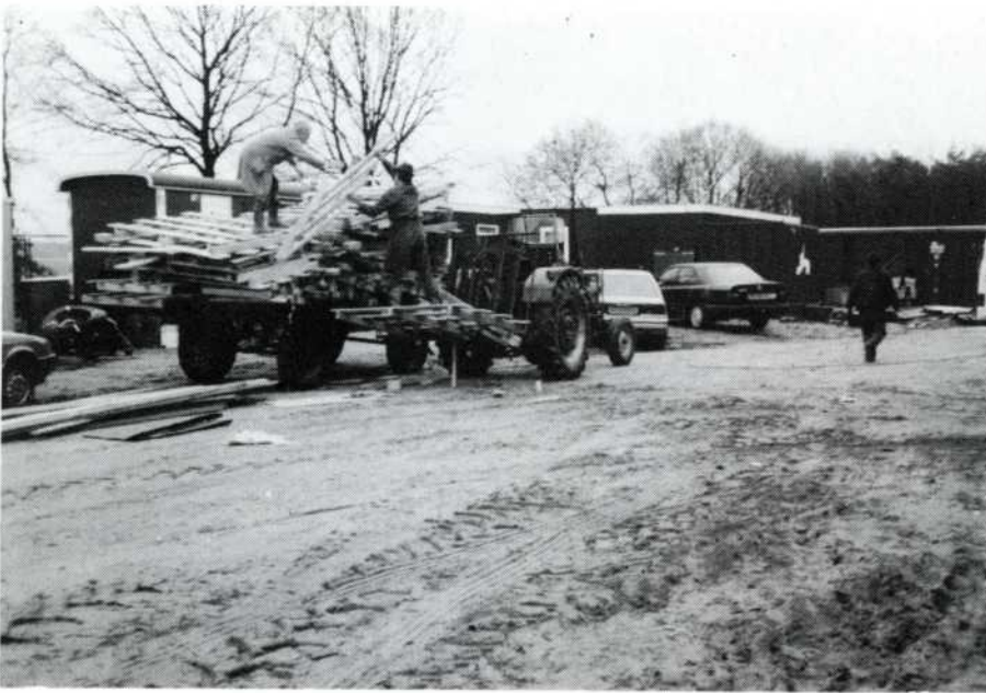
* Een van de zelfwerkzaamheidsklussen van de fanfare (opruimen (in nieuwbouw loodsen ja. Theeuwen).
