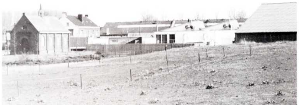
*het plaatselijk bedrijf Beerkens B.V. (waar ééns de BLITTA domicilie had), breidde gestaag uit, en paste aan.
